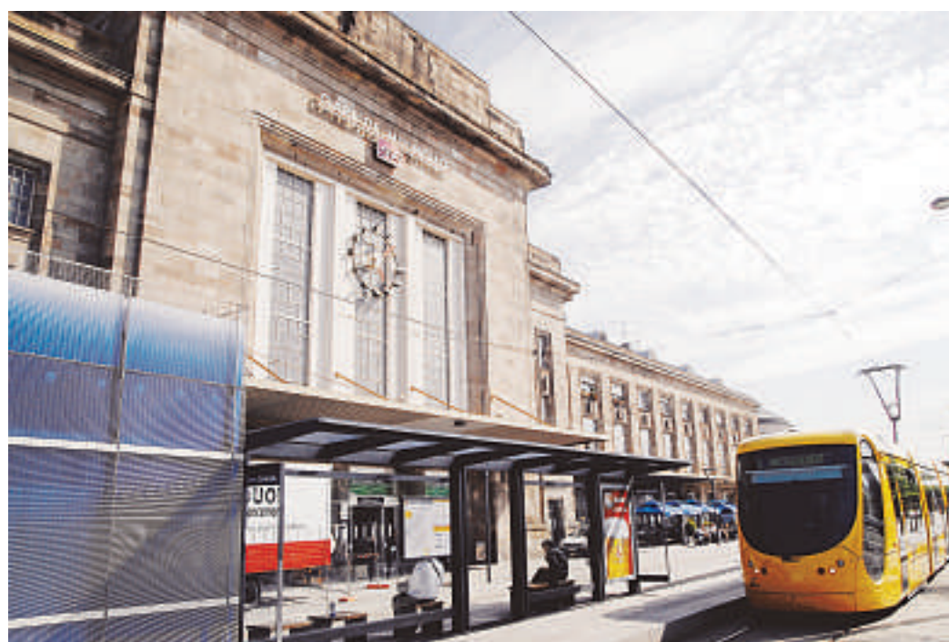
Le site avec sa gare...La SNCF démarrera pour sa part et dans les prochains temps d'importants travaux de rénovation, avec le rafraîchissement des façades et le changement de la verrière qui surplombe l'entrée des halls. Un premier pas dans ce qui sera le futur quartier d'affaires de la ville. (Photo archives DNA)
